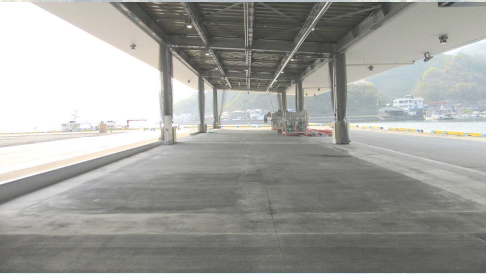
水揚げされた水産物をそのまま大型トラックに積み込める
