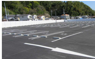
駐車場を囲う防音壁 車両の騒音を低減
